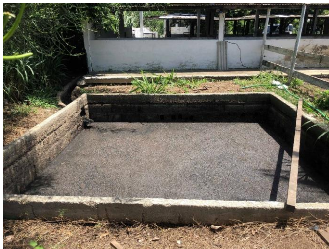
Figura 1. Esterqueira da agroindústria com armazenamento de dejetos suínos. Fonte: Autora, 2018
