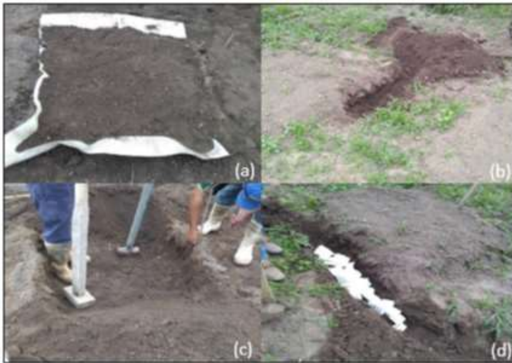
Figura 1 - Construção dos canteiros correspondentes ao T2 e T3. Canteiro com lona (a); Construção dos drenos laterais (b); Construção dos canteiros compactados (c); Utilização de isopor como material inerte drenante dos drenos laterais (d).
