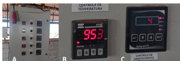
Figura 6: Painel de controle da temperatura e abastecimento de fonte energética da indústria 3. Fonte: os autores.
